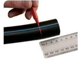
2. Marquer le tube à l'aide d'un feutre pour visualiser la longueur d'emboîtement du tube dans le raccord.
